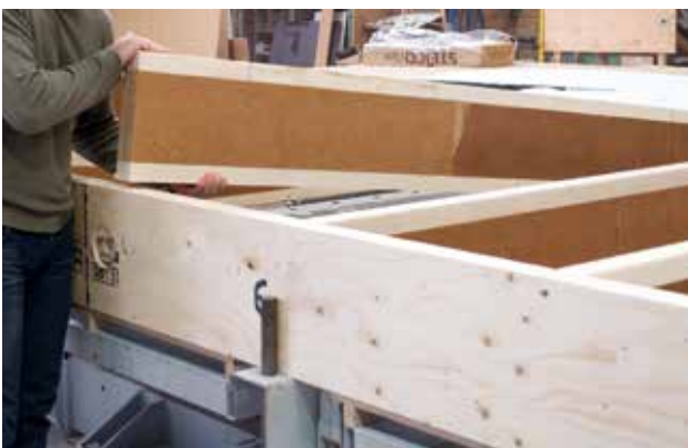
Vorfertigung von Wandelementen mit STEICO LVL R und STEICO Stegträgern
