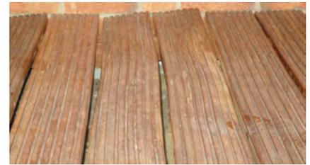
**Wechsel-Dreh-Wuchs:** Harthölzer neigen teilweise stärker zum sogenannten Wechsel-Dreh-Wuchs. Es ist daher besonders wichtig, dass die empfohlenen Abstände zwischen den Auflagepunkten auf der Unterkonstruktion eingehalten werden, damit das Holz „gehalten“ werden kann.
